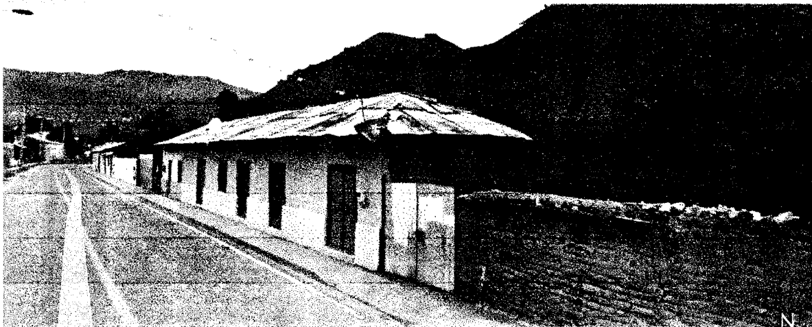
Fig. 3 y 4: Vista fachada principal, desde exterior
